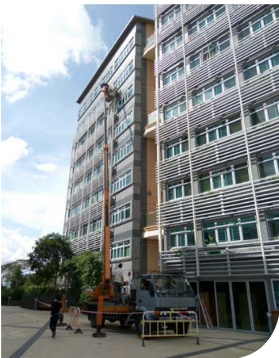
External wall works 外牆工程
